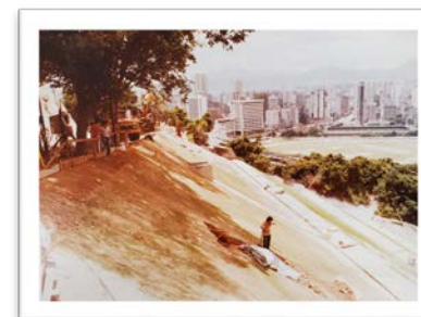
在养和医院进行的斜坡维修工程，旁为跑马地马场（1977 年）（参考编号：HKRS2118-4-1）
